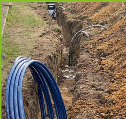
Ein langer Graben ermöglicht das Verbinden der drei SONDENSYSTEME miteinander.
