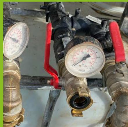
Befüllen der Außenanlage mit einem speziellen Frostschutzmittel.
