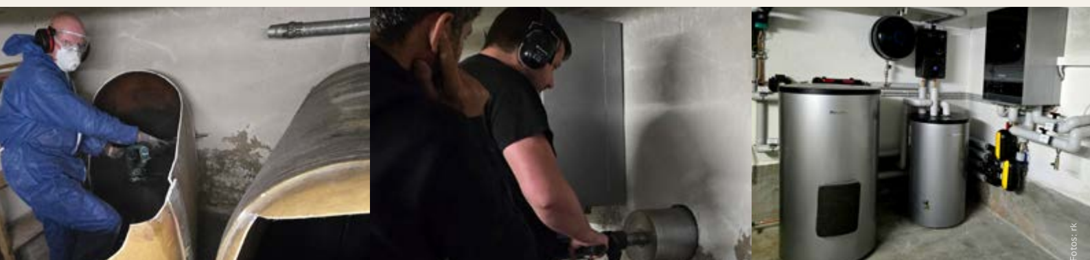
Vom Zerkleinern und Entsorgen der alten Tanks (links), über die Kernbohrung für die neuen Leitungen zur Außeneinheit (mitte) und die neue Heizungsanlage (rechts): So geht es in die Zukunft.
